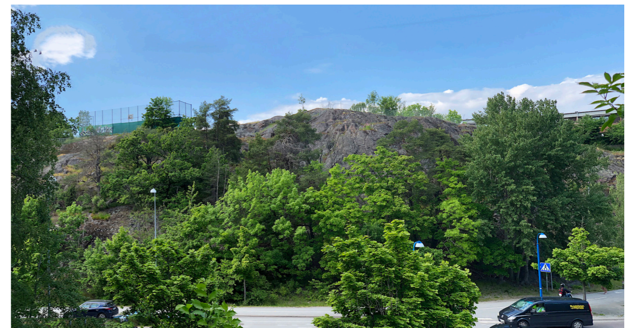
Bild 7: Bergvägg längs Kvarnholmsvägen.
