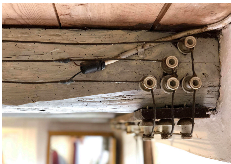
Bild 35: Gammal men ännu fullt fungerande el-dragning i uthus på Gotland. Vackert och enkelt - men brandfarligt?
