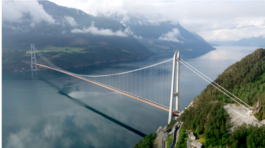
Hardangerbrua utanför Oslo. Bild: Wikipedia via Flickr Fotograf: Kronja
